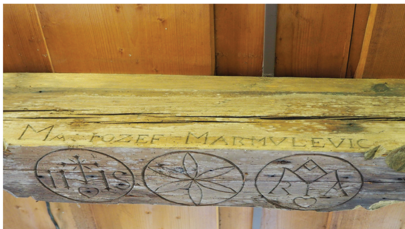
Wnętrze domu z Chrzanowa, fragment inskrypcji; fot. P. Bujakiewicz
