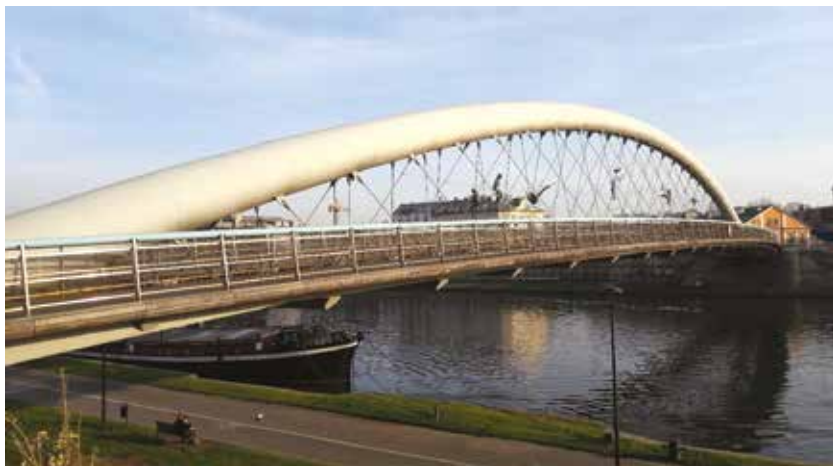
Widok kładki od zachodu;
