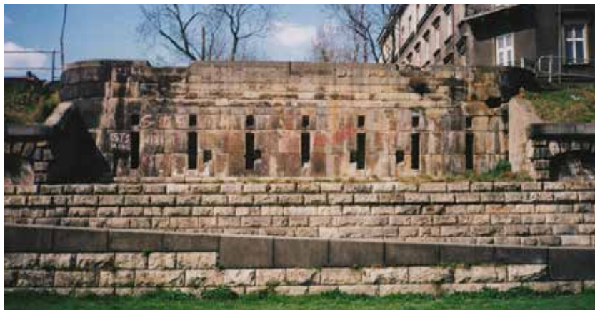
Przyczółek mostu Podgórskiego od strony Kazimierza;
