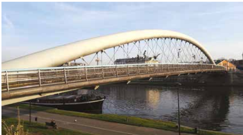
Widok kładki od zachodu;
