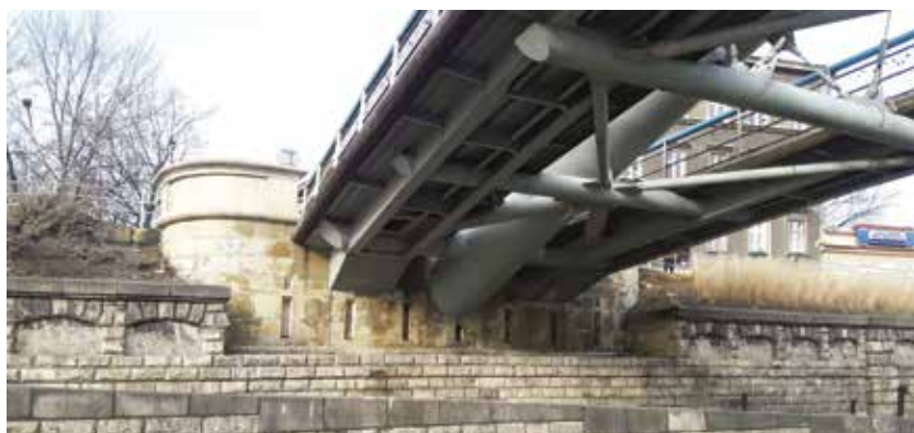
Oparcie konstrukcji kładki na przyczółku mostu Podgórskiego;
