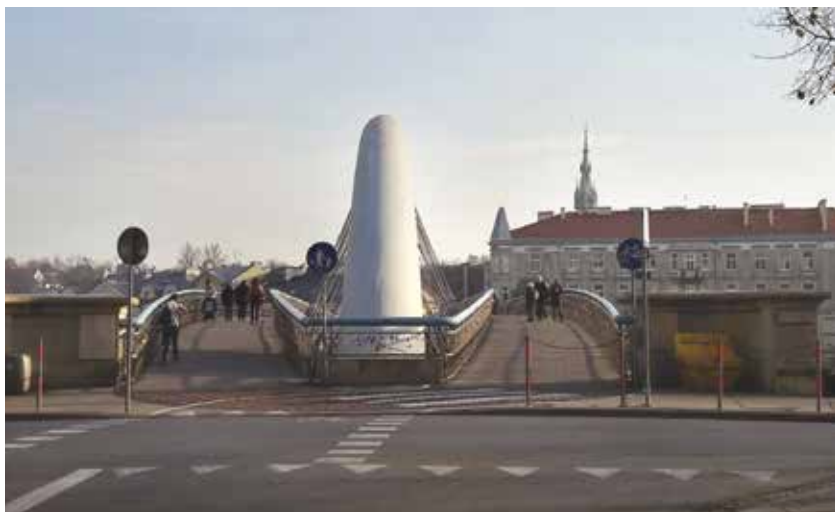
Wejście na kładkę od strony Kazimierza;
