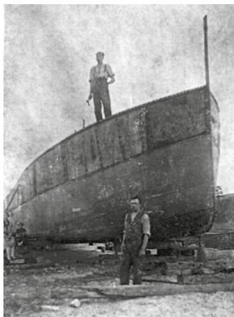
Budowa statku „Katowice”. Z archiwum rodziny Sapoków
