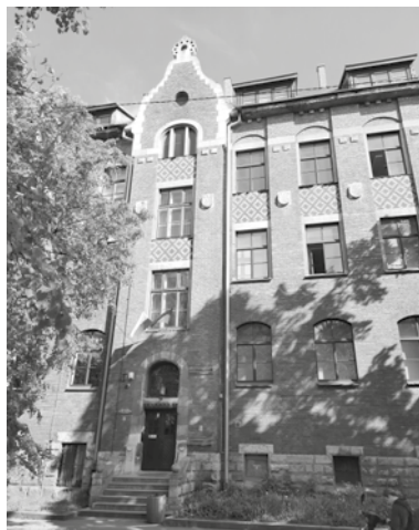
Budynek szkoły przy ul. Humberta 3.
