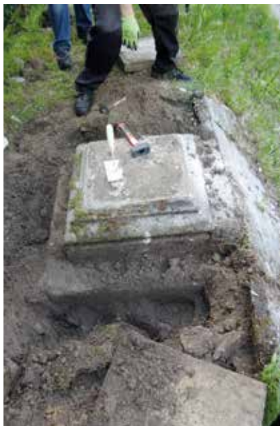
Odstonięty cokół podczas prowadzonych prac konserwatorskich. Fot. ze zbiorów Stan-Art Stanisław Czech
