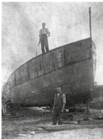
Budowa statku „Katowice”. Z archiwum rodziny Sapoków
